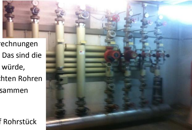
Ausgangspunkt für alle Berechnungen ist das Mass „Mitte-Mitte“ Das sind die Längen, die man brauchen würde, wenn man an Stelle von echten Rohren einfach dünne Strecken zusammen fügen würde.
